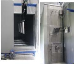
Der Haftwassertrockner ist mit einer DUO-Voll-Hybrid-Beheizung (Gas / elektrisch) sowie mit einer WRG-Nutzung der Pulverofen-Abwärme ausgestattet.
